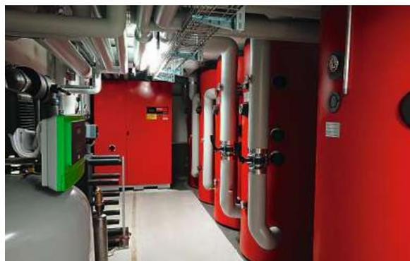
*Klimafreundliche Grundwasser-Wärmepumpe ersetzt Ölheizung in der «Alten Post»*
