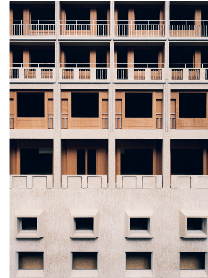
Modell für das Alterszentrum St. Josef Kloster Ingenbohl, Stampflehm Trasskalk, MDF, Birnenholz, Fichtenholz, Acrylplatten, Aluminiumrohre, Stahlstäbe; 1:50, 91x70x77cm
