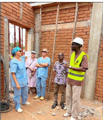
Niggi Wiederkehr (links) besichtigt mit Kollegen die Baustelle in Vogan.
