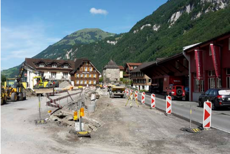
Umbau Parkplatz Ochsen
