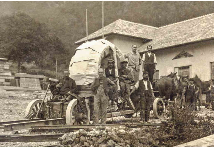
Anlieferung des Generators mit einem Sechsspänner, 1926
